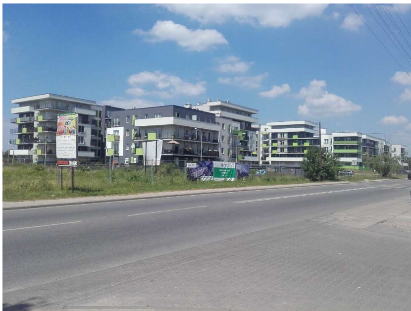
Fot. 4.11. Dominanta gabarytowa – osiedle „Nowe Złotno”
