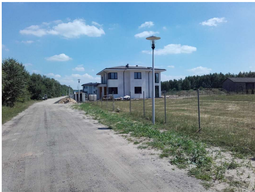
Fot. 4.22. Stare Złotno. Powstające niezgodnie z miejscowym planem zagospodarowania przestrzennego zamknięte osiedle „Złota Aleja”
