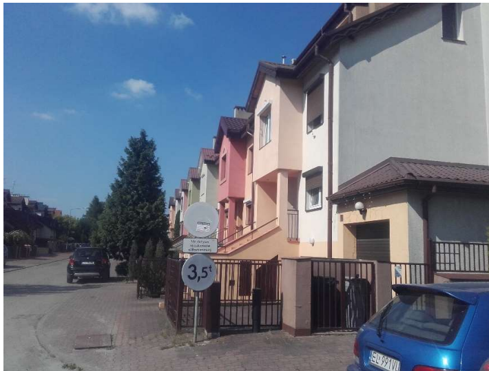
Fot. 3.1. Domy szeregowie powstałe w latach 80. XX wieku 15
