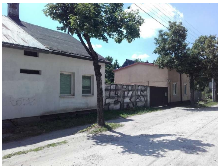
Fot. 4.12. Zabudowa pierzejowa przy ul. Cyganka
